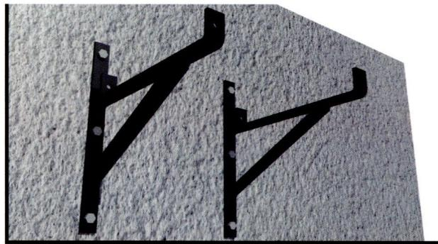
Konzoly je treba upevniť priamo na stenu pomocou ocelových rozpěrnych kotiev KS 8x80. Potom na ne priskrutkujeme kominársku lávku.
